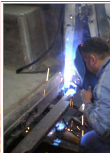
Слика бр. 8. Искри добиени при заварување на метал
